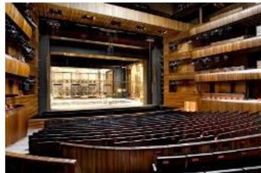
Revestimento para obtenção de isolamento acústico
